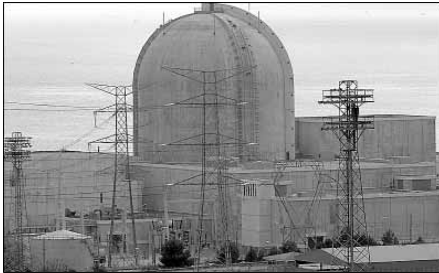
Instal·lacions de la central Vandellòs II
