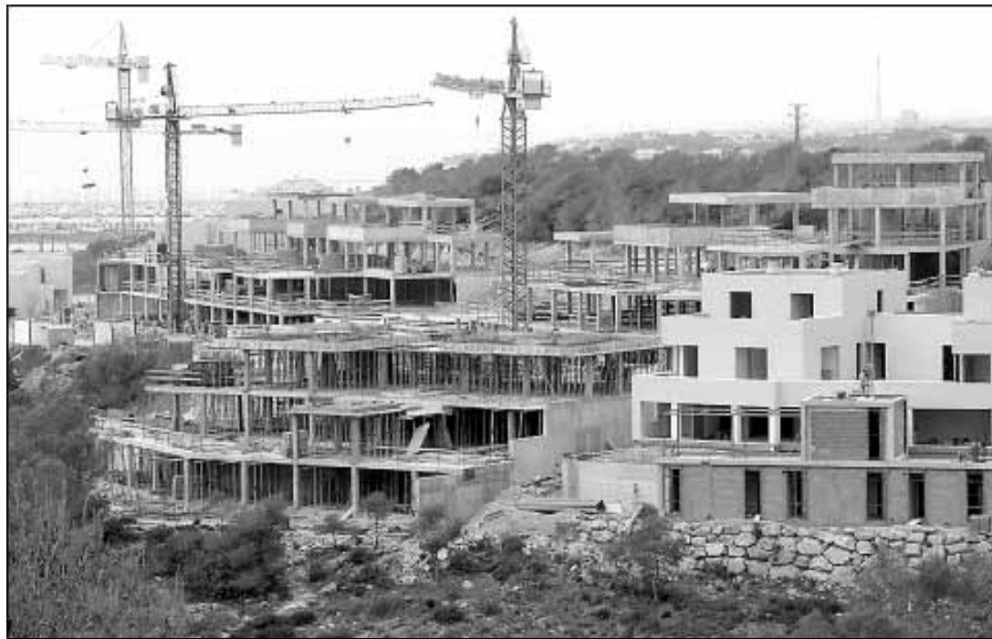
Habitatges en construcció a Sant Pere de Ribes
