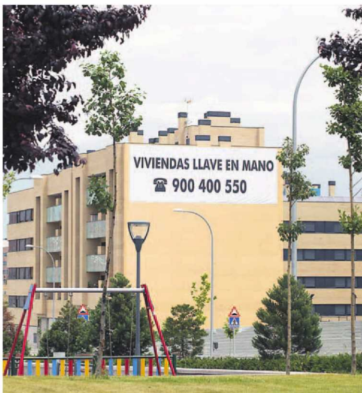
Bloque de viviendas en venta. PABLO MONGE
