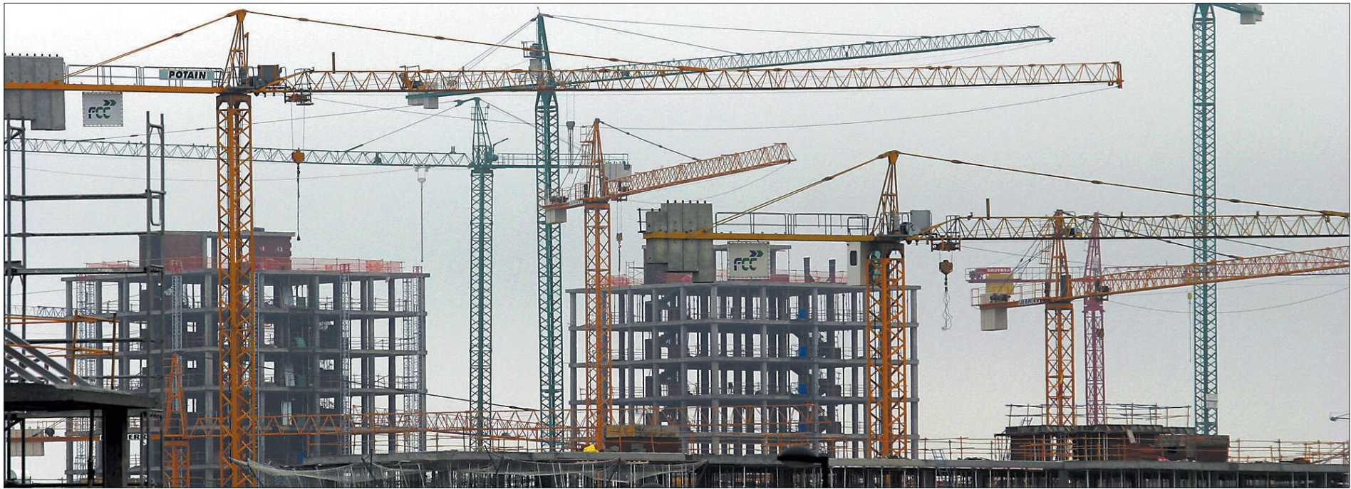
Edificios en construcción y grúas al este de Parla (Madrid). / CLAUDIO ÁLVAREZ
