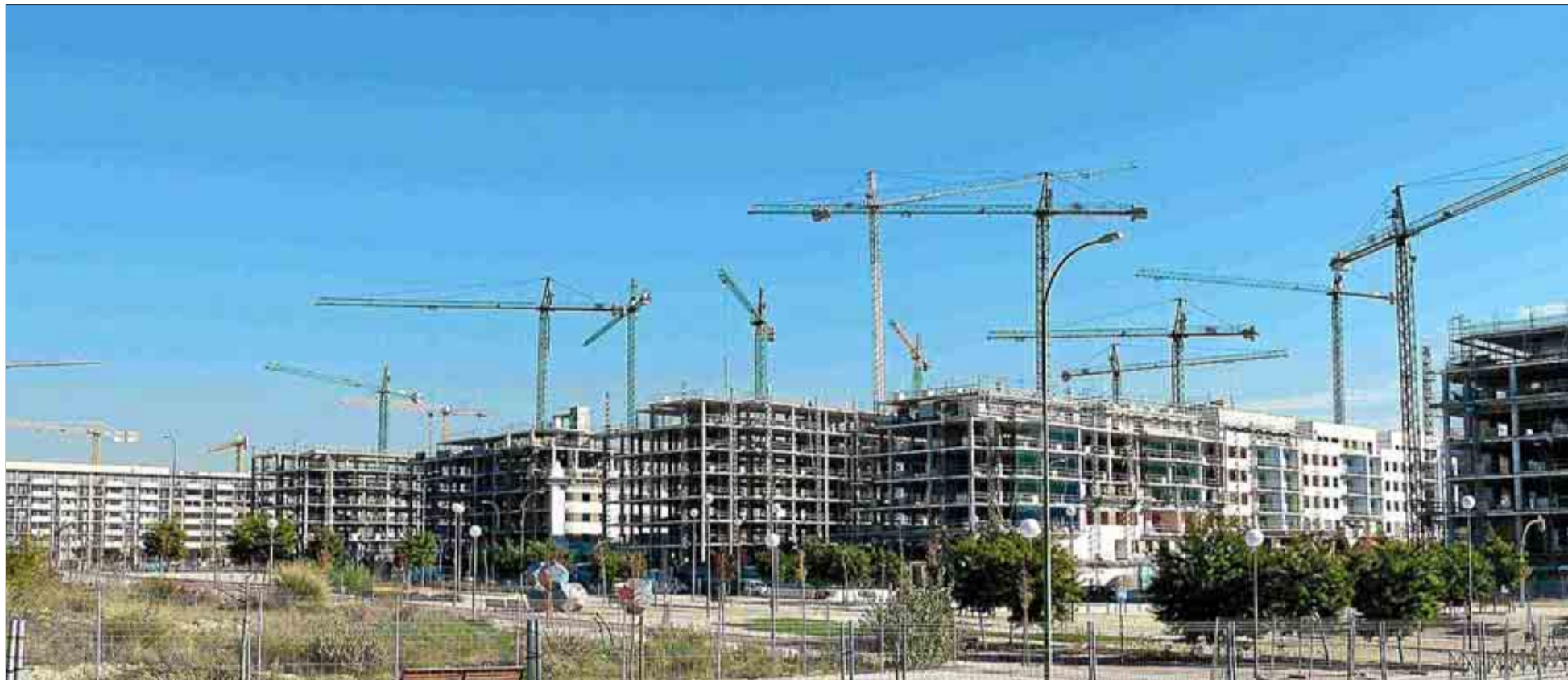
Múltiples grúas levantan varios edificios de pisos en el nuevo barrio madrileño de Arroyo del Fresno, al norte de la capital, desde principios de 2014. / EL MUNDO
