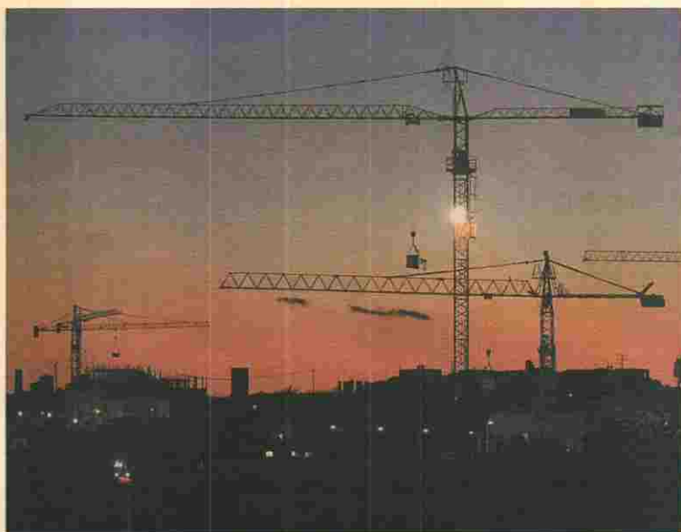
Construcción de viviendas en Palomares (Almería). / FRANCISCO BONILLA
