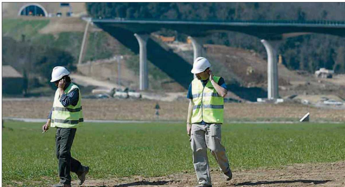
Operaris de l'empresa encarregada de la construcció del túnel de Bracons el març d'aquest any ■ CLICK ART FOTO / ARXIU
