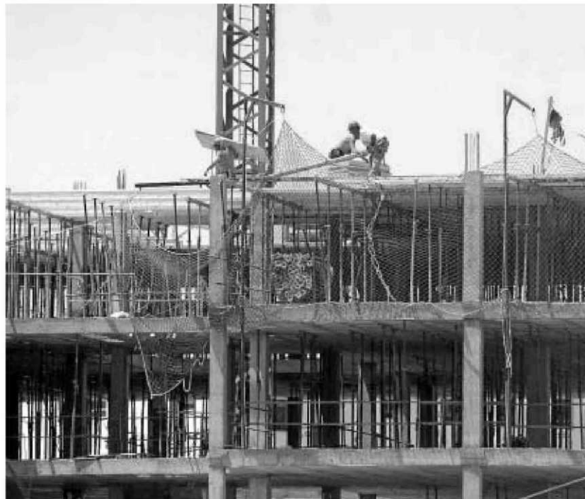
Un bloque de pisos en construcción en la capital.
