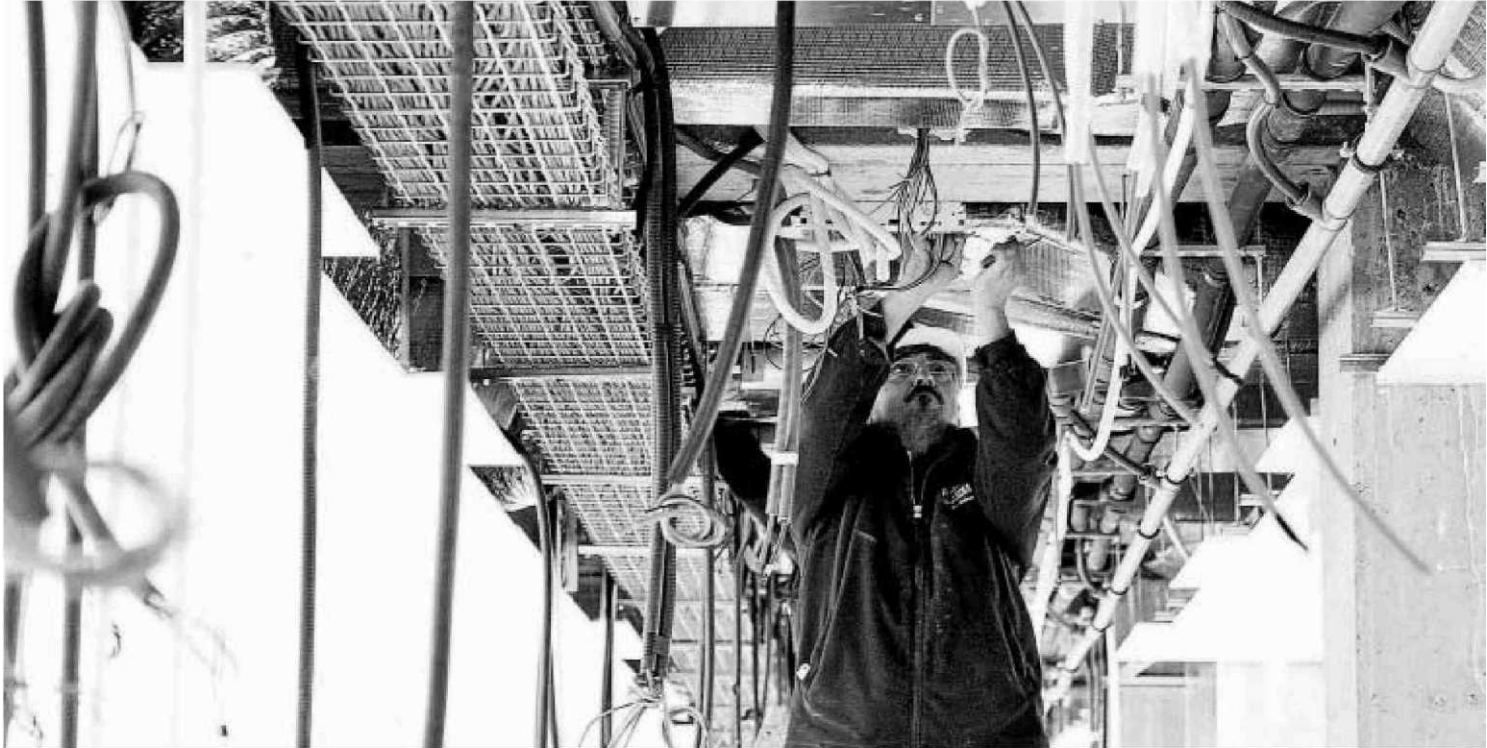
Un obrero trabaja en la construcción de un inmueble.
