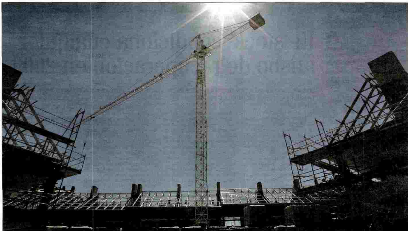
Imagen de una promoción de viviendas en plena construcción. / J. C. HIDALGO / EFE
