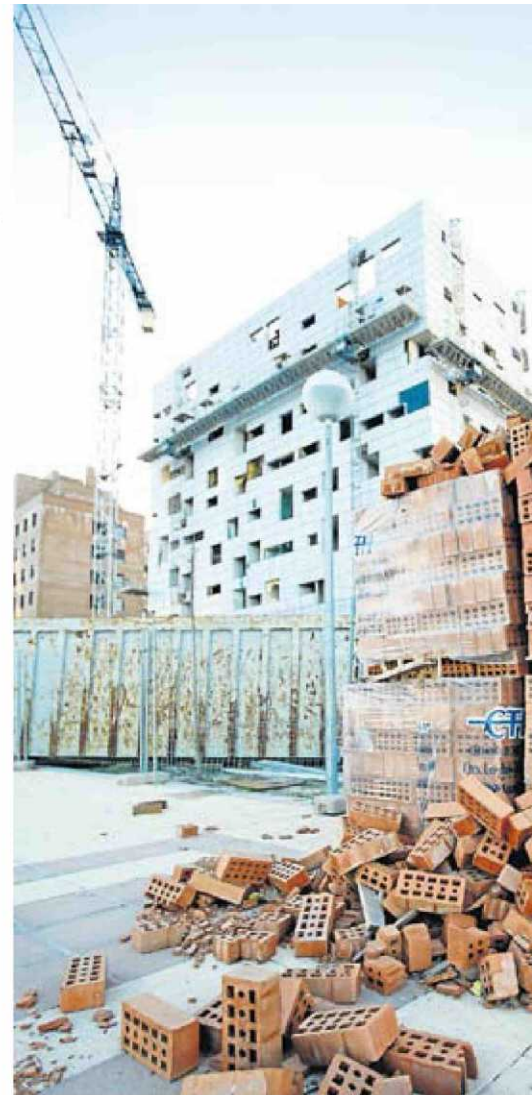
Edificios en construcción en Madrid. BLANCA DEL AMO
