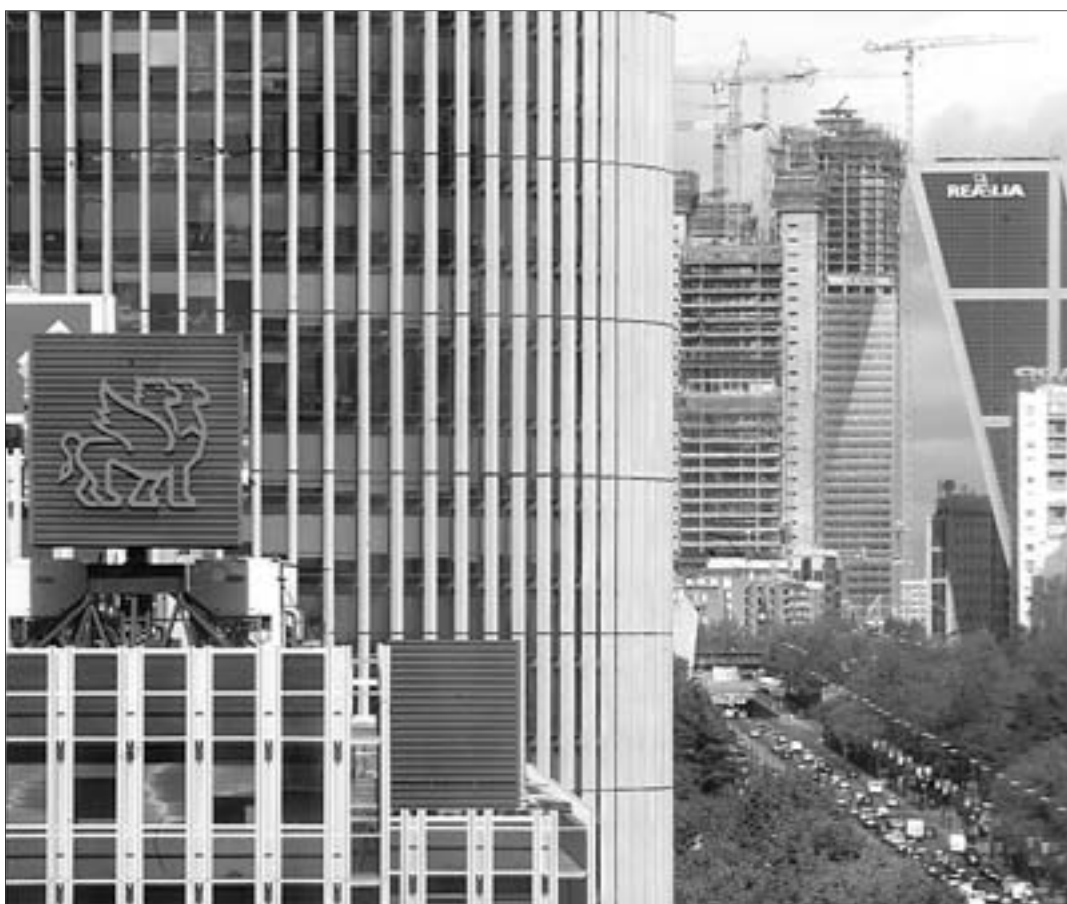
Vista panorámica del edificio de Realia en la madrileña Plaza de Castilla. PABLO MONGE
